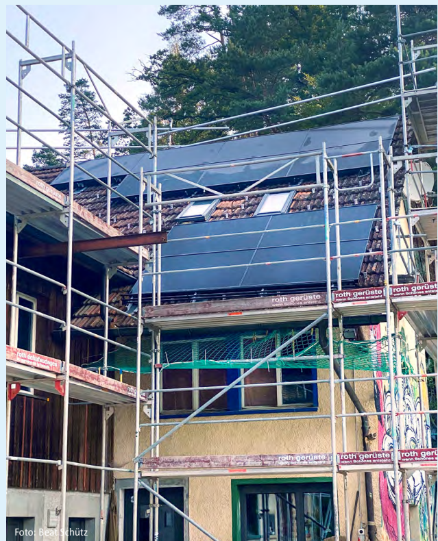
Montage der Solarmodule auf dem Dach des Bauernhauses des Grienen
