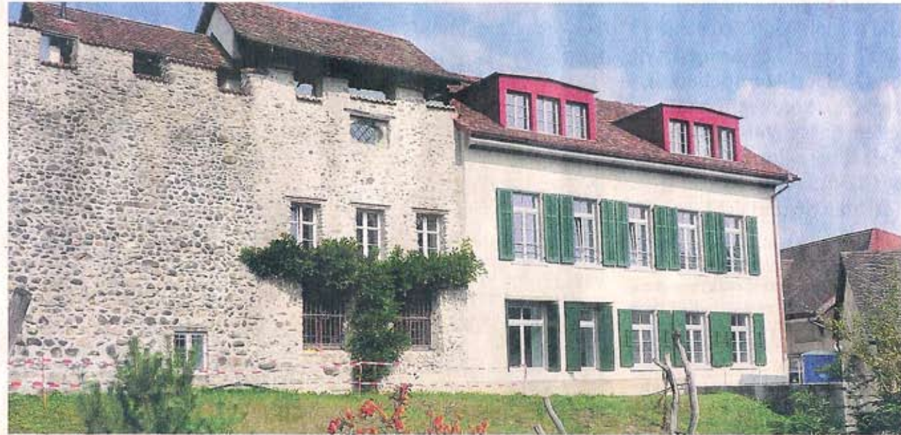
Aus denkmalpflegerischer Sicht musste die Fassade erhalten bleiben. Bilder: Werner Angst
