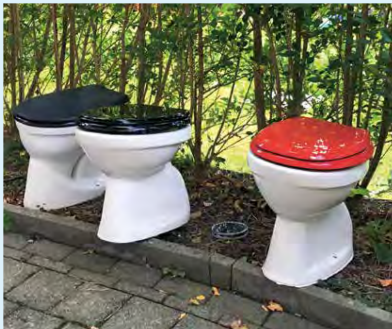
Erneuerung mit Augenmass an der Eichliackerstrasse: Nach der Renovierung der WCs wurden die bestehenden Toilettenschüsseln wieder eingebaut – in der Zwischenzeit fanden sie im Garten ein Plätzchen.
